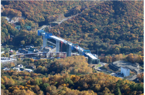
写真①:朝里川橋の施工状況
