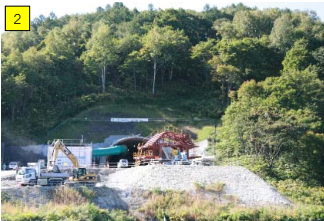
【第二天神トンネル東坑口】
