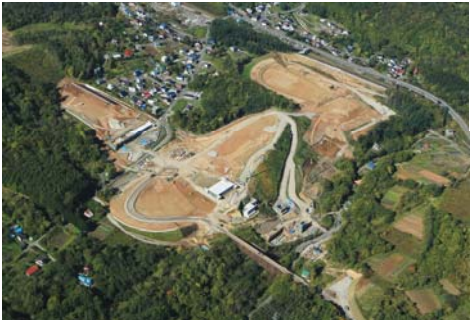
写真②:小樽西IC(仮称)の施工状況
